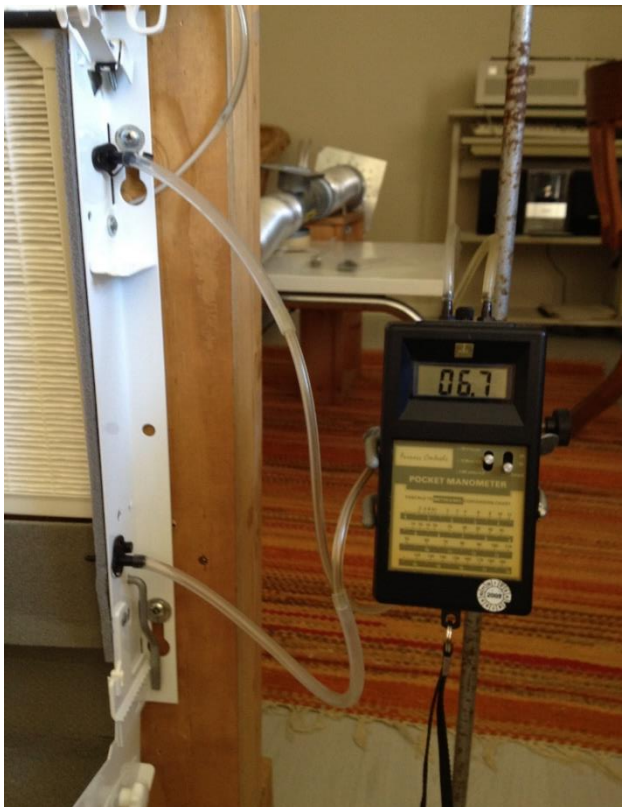
Tryckdifferens över filter F7 vid luftflödet 10 l/s
